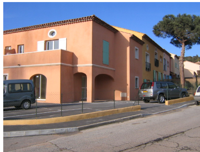
Logements pour actifs réalisés par la SEM de Sainte-Maxime
